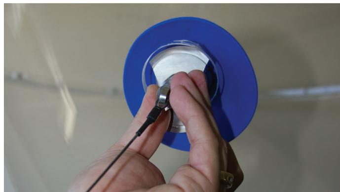
5. Poser la plaque d'alignement Fast-Fit™ sur le câble de retenue (ou le mamelon) et dans la cuve avec l'épaulement vers l'extérieur. Centrer la plaque d'alignement dans l'orifice de pose, en l'alignant en position verticale avec la flèche pointée vers le haut.
